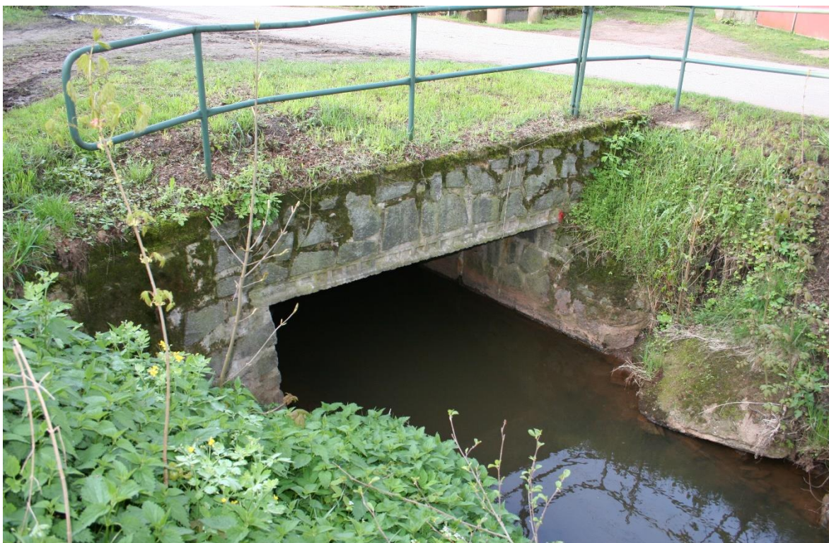
Obr. 4: Fotografie mostní konstrukce pro umístění vodoměrné stanice č. 1 ve městě Pilníkov.
