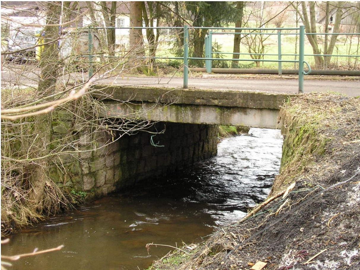
Obr. 8: Fotografie mostní konstrukce pro umístění vodoměrné stanice č. 2 ve městě Pilníkov.
